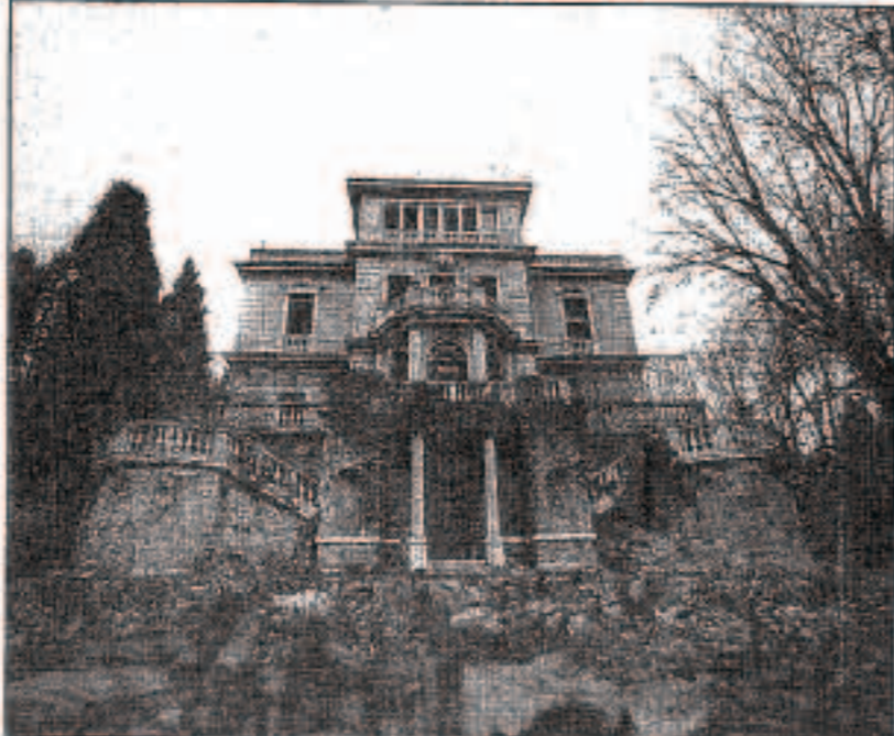
Un'immagine recente di Villa Cosulich, edificio di straordinaria bellezza abbandonato a se stesso da tempi immemorabili. Scelta un anno fa come sede ideale dell'Iap oggi è rimasta tale e quale, immobile nel suo degrado.
